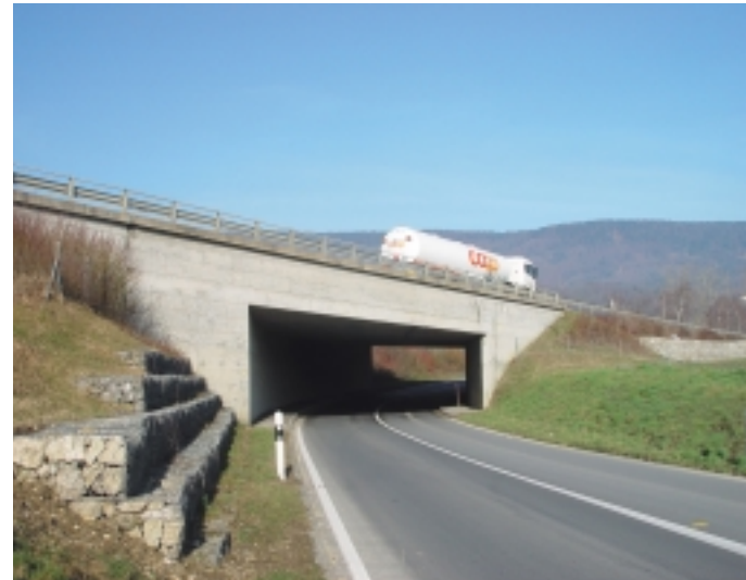
Inspection du passage inférieur A5 de Wavre. Inspektion der Unterführung der A5 in Wavre.
