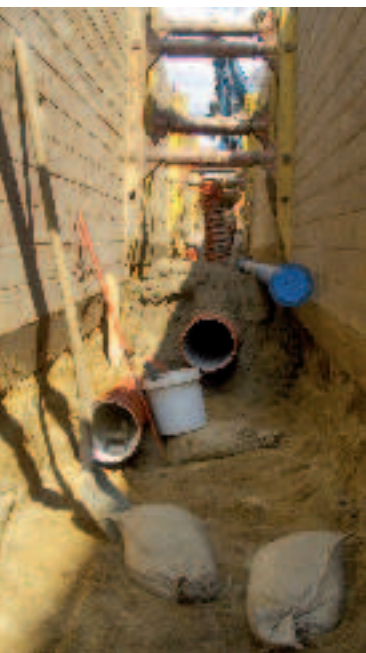
Tranchée selon la méthode RSS® – Sols fluides. RSS® – Flüssigbodengraben.
