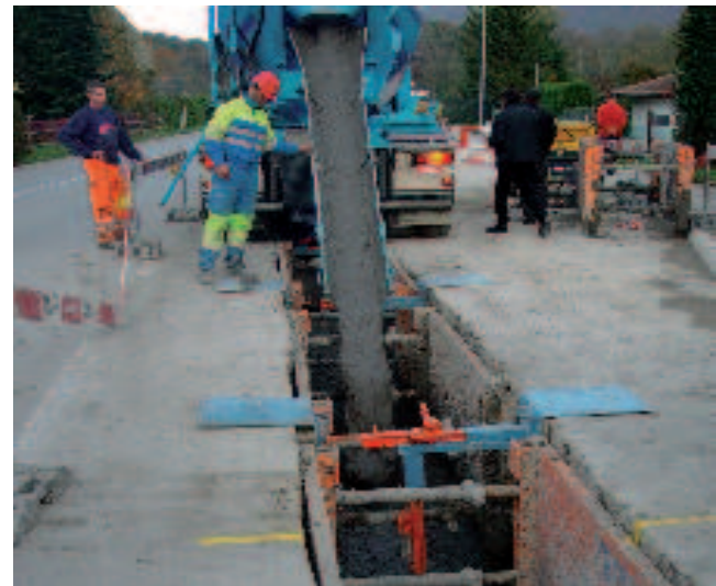
Mise en place du sol fluide... Einbau des Flüssigbodens...
