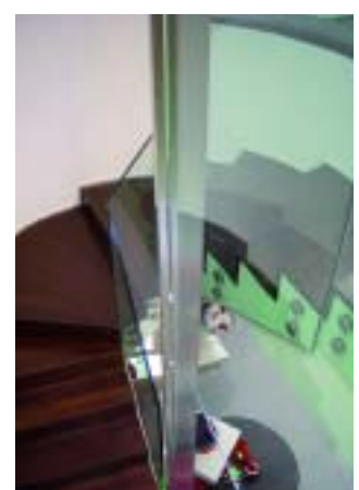
Escalier interne terminé. Vollendete Treppe.
