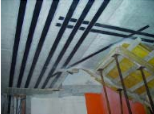
Lamelles précontraintes collées. Verklebte vorgespannte Lamellen.
