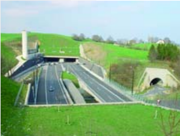
A5 La Béroche: demi-jonction de St-Aubin. A5 La Béroche: Halbinschluss St-Aubin.
