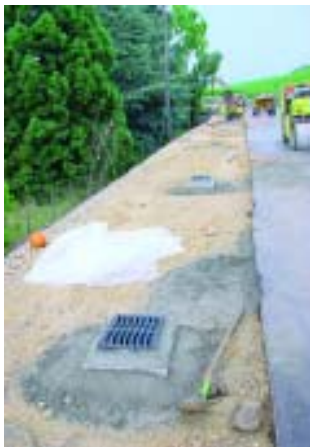
Création d'un trottoir. Neuer Fussweg.
