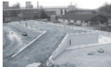
Rampe de déchargement en construction Abladerampe im Bau
