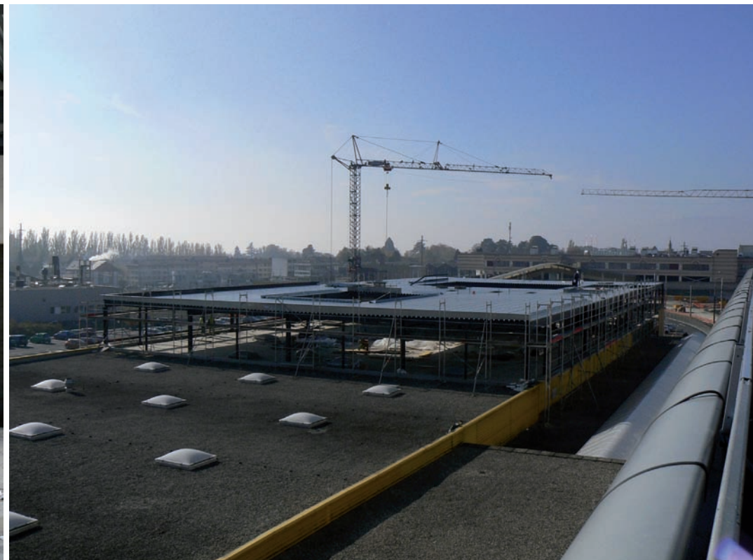
Construction d'un étage supplémentaire Bau einer zusätzlichen Etage
