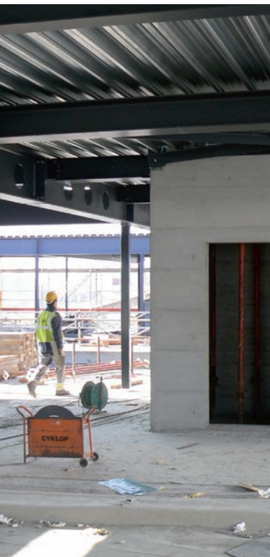
Nouvelle cage d'ascenseur Neuer Liftschacht
