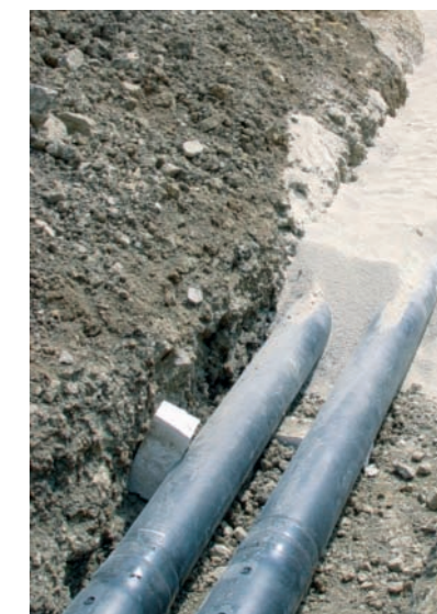
Conduite dans une fouille traditionnelle. Leitung im Graben.
