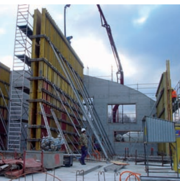
Coffrage de la paroi centrale. Wandschalung.
