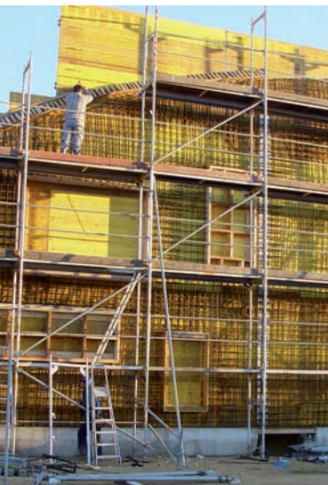
Armature de la paroi ouest. Wandarmierung.
