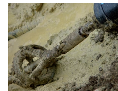
Tirage d'une conduite dans un forage dirigé. Leitungsherstellung im Richtbohrverfahren.
