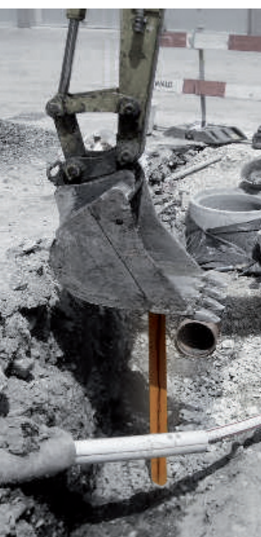
Pieux de soutien des canalisations Stützpfähle der Kanalisation
