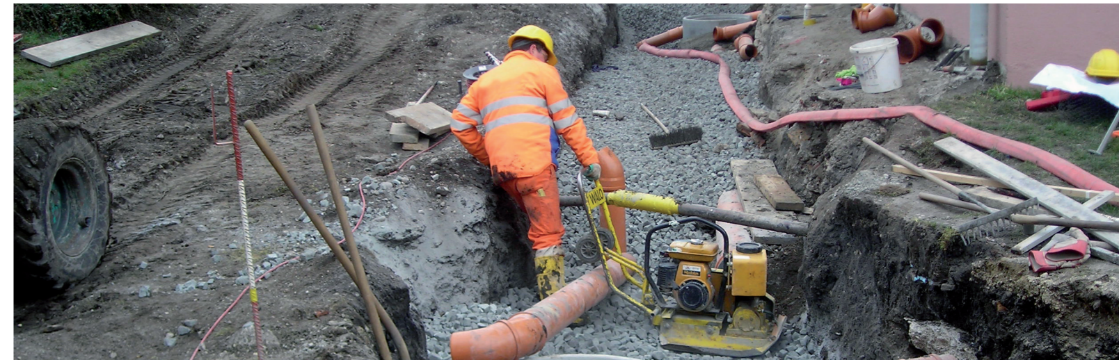
Remblayage avec des matériaux légers Aufschüttung mit leichten Baustoffen
