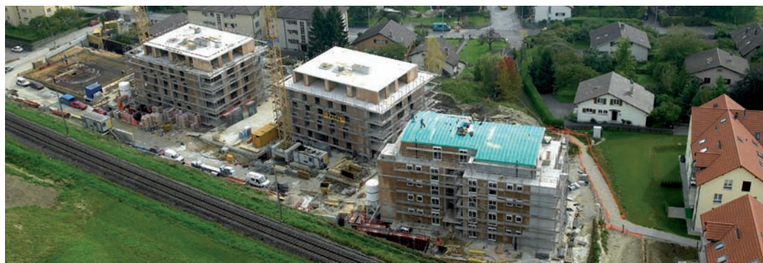
Vue aérienne des immeubles en construction Luftaufnahme der im Bau stehenden Gebäude
