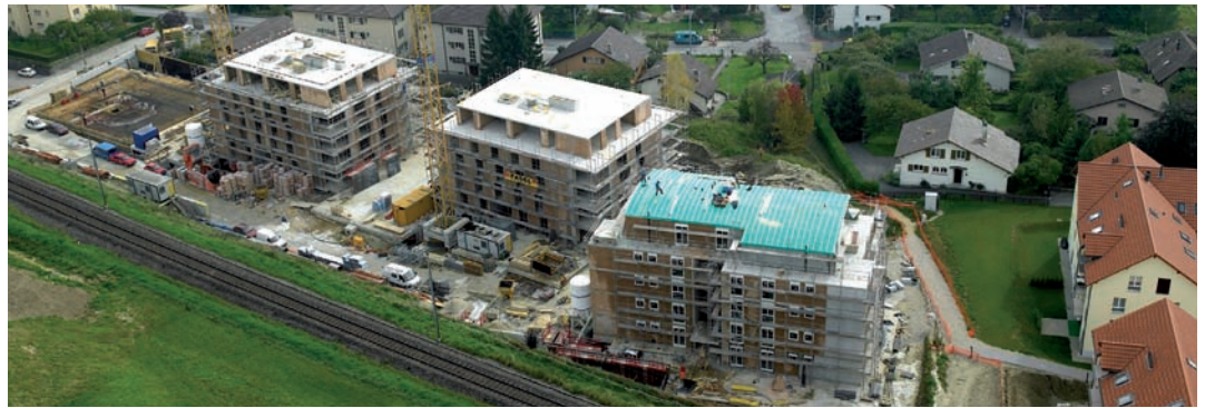
Vue aérienne des immeubles en construction Luftaufnahme der im Bau stehenden Gebäude
