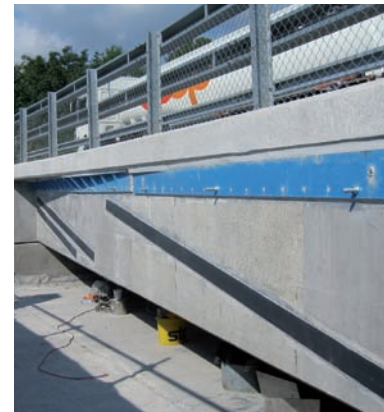
Travaux d'assainissement et de renforcement. Erneuerungs- und Verstärkungsarbeiten.
