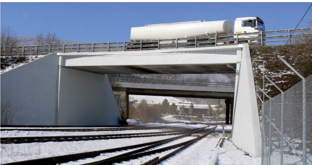
Pont remis en état, après travaux. Restaurierte Brücke.
