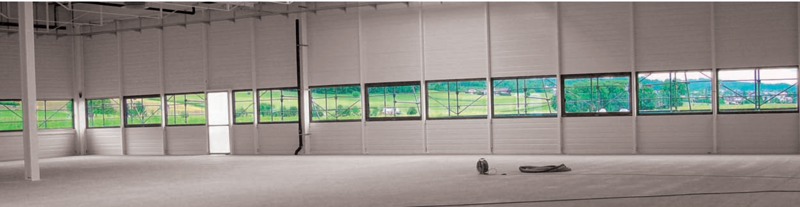
Zone de production sans pilier. Stützenfreie Produktionszone.
